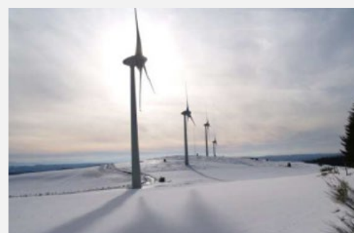
Pôle éolien des MONTS DE LACAUNE Département : Tarn (81), Aveyron (12) Puissance électrique : 74 MW 31 éoliennes, 6 parcs Mise en service : 2006 – 2008 – 2011
