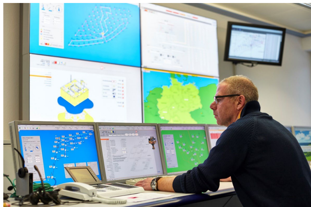
Illustration 3 : Conduite opérationnelle des installations de production au sein du Centre d'Exploitation de Barhöft
